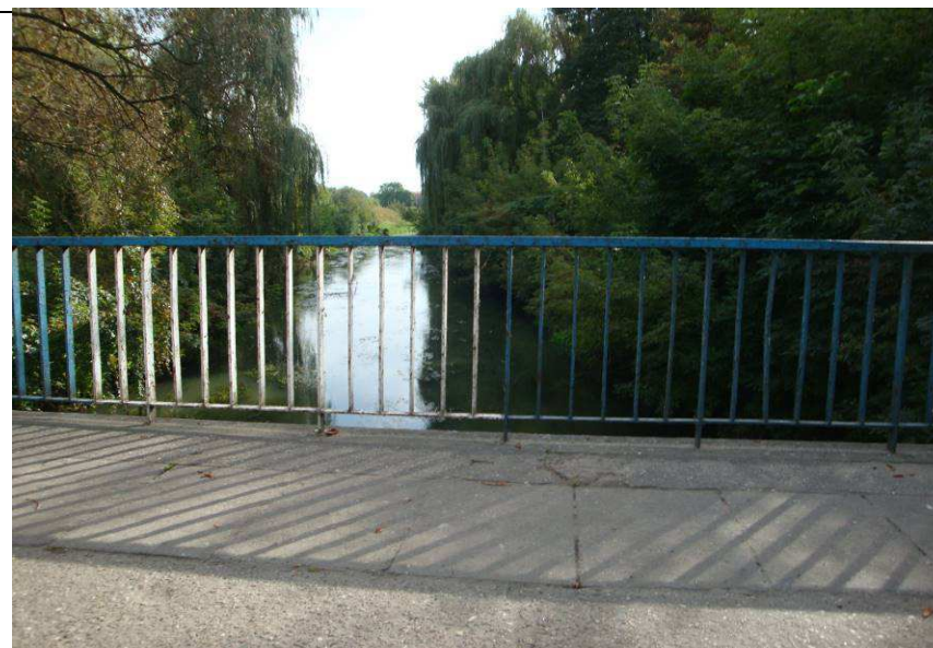
Fot. 9 Rzeka Czarna Przemsza/wschodnia granica obszaru zmiany mpzp – widok w kier. południowym z mostu w ciągu ul. Rybnej.
