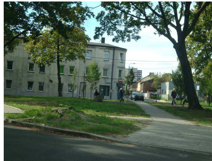
Fot. 11 Typowa zabudowa w dzielnicy/ul. Kopernika – widok od strony skrzyżowania
