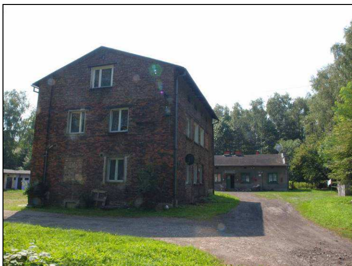
Fot. 6 Zabudowania dawnej kopalni Dorota w rejonie ul. S. Starzyńskiego, obecnie zabudowa mieszkaniowa.
