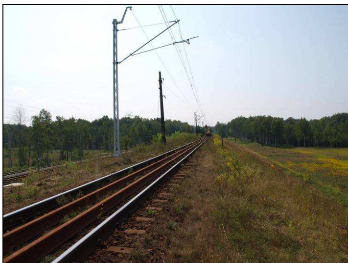
Fot. 14 Linia kolejowa nr 133 Dąbrowa Górnicza Zabkowice – Kraków Główny, północno-wschodnia część obszaru.
