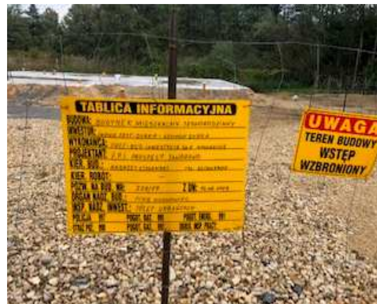
Fot. 45 Zmiany zagospodarowania na terenie 69bMN przy ul. Kolonia Wągródka
