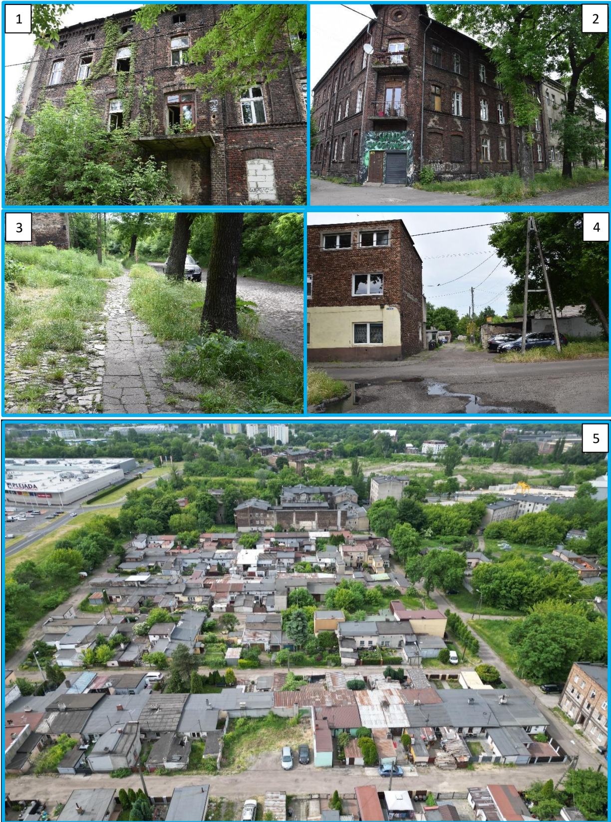
1-2. Zdekaptalizowana tkanka mieszkaniowa na ulicy Robotniczej. 3. Zły stan dróg i chodników. 4. Brak kanalizacji. 5. Widok na zdekaptalizowaną tkankę mieszkaniową dzielnicy.
