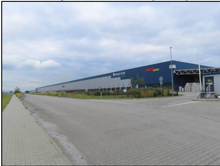
Fot. 6 Zachodnia część terenu, widok w kierunku wschodnim
